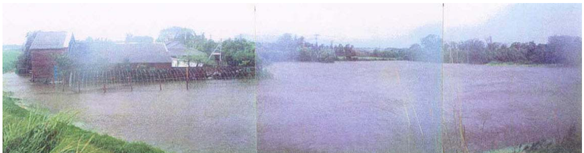
写真 1.2.10 串良川左岸 0k600 付近 堤内地浸水状況
