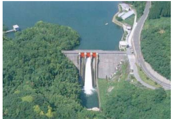
写真 1.3.2 高隈ダム（支川串良川）
