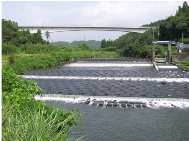
写真 1.3.1 林田堰（支川串良川）
