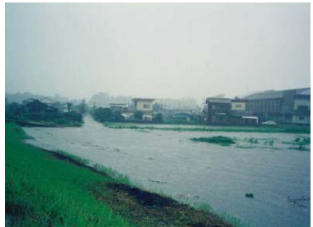
写真 1.2.8 高山川左岸 2k000 付近 堤内地浸水状況
