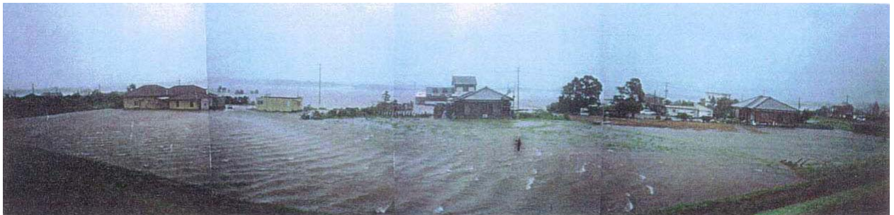
写真 1.2.9 肝属川右岸 8k600 付近 堤内地浸水状況
