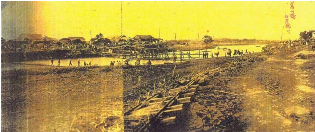
写真 1.2.1 高山川 2k300*付近（高山橋）被害状況
