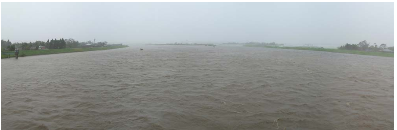
写真 1.2.14 基準地点俣瀬地点（肝属川 3k900）における河道内の状況
